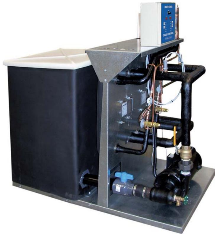
Lorsque vous utilisez un groupe frigorifique Chiller Compact en combinaison avec un échangeur de chaleur à plaques Mueller Accu-Therm<sup>®</sup>, vous pouvez soit refroidir soit prérefroidir votre lait, en fonction de son débit.
